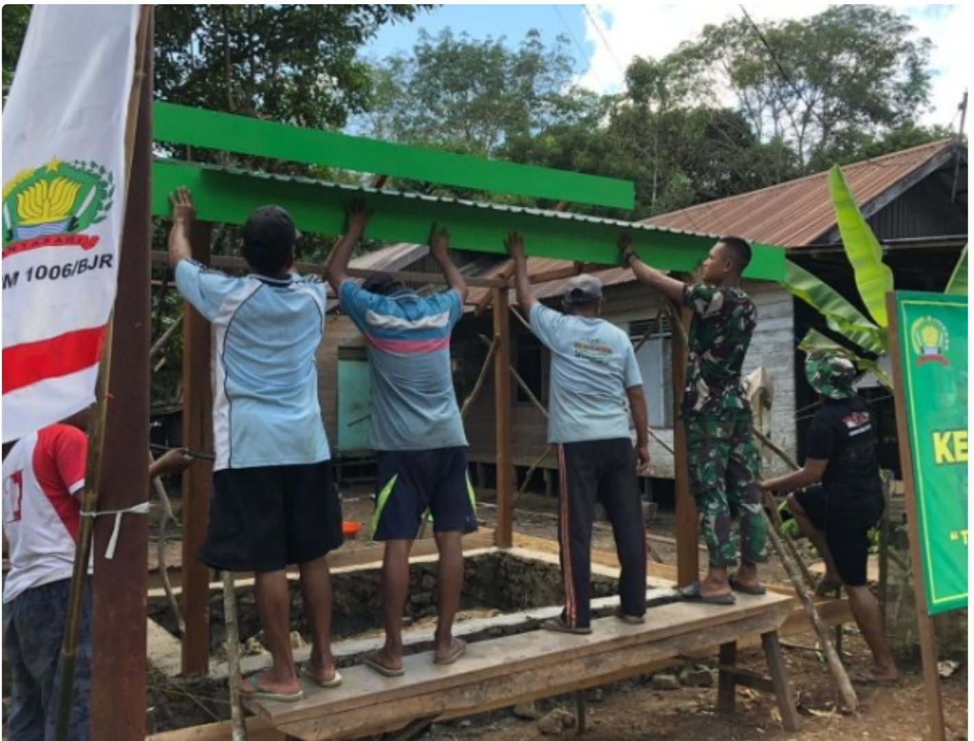
Pemasangan Atap Poskamling sasaran TMMD ke-113 Kodim 1006/Banjar
