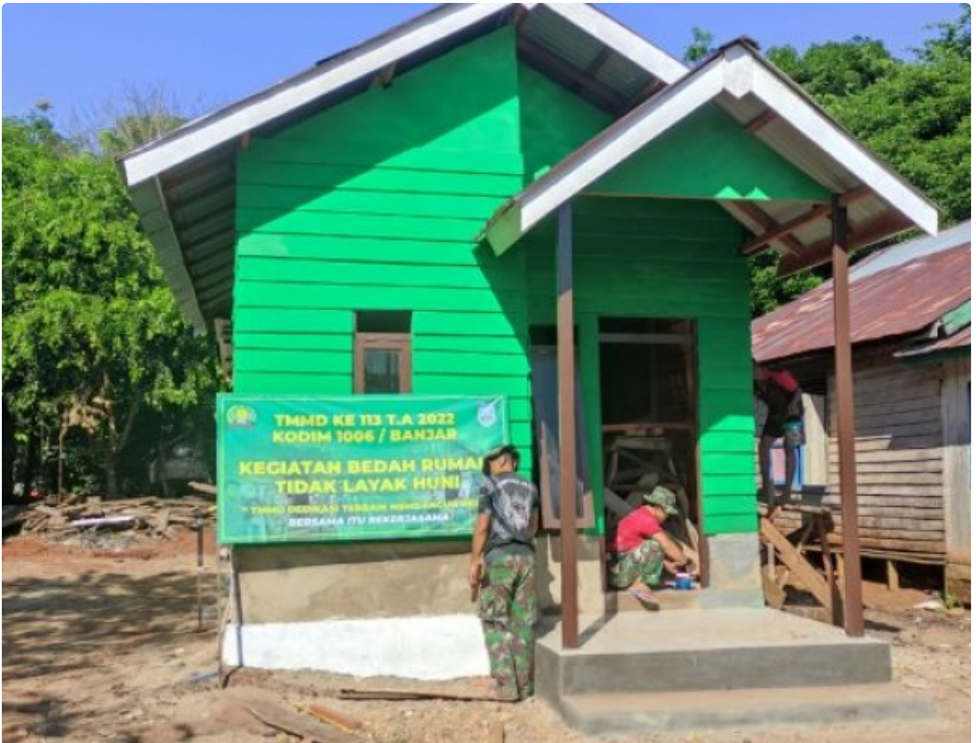
Pembangunan Teras RTLH Program TMMD ke-113 Kodim 1006/Banjar
