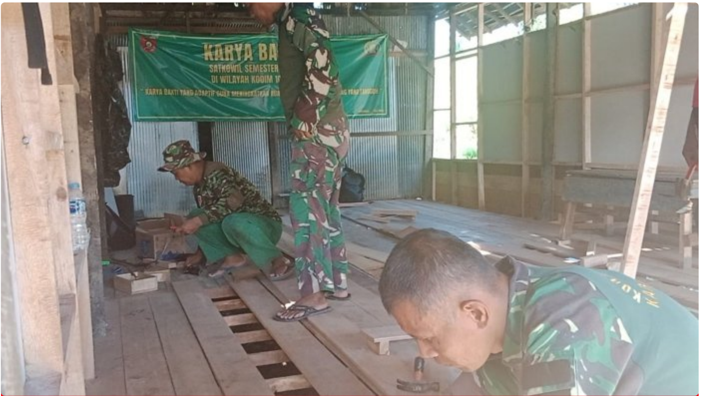
Rehab Rumah RTLH Karya Bakti TNI Kodim 1006/Banjar Hampir Rampung Pengerjaannya
