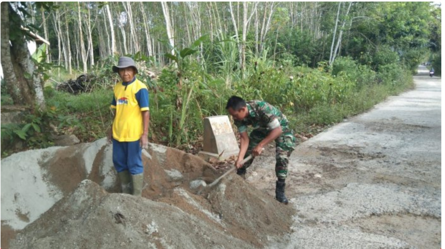
Babinsa Bantu Gotong Royong Pengecoran Jalan
