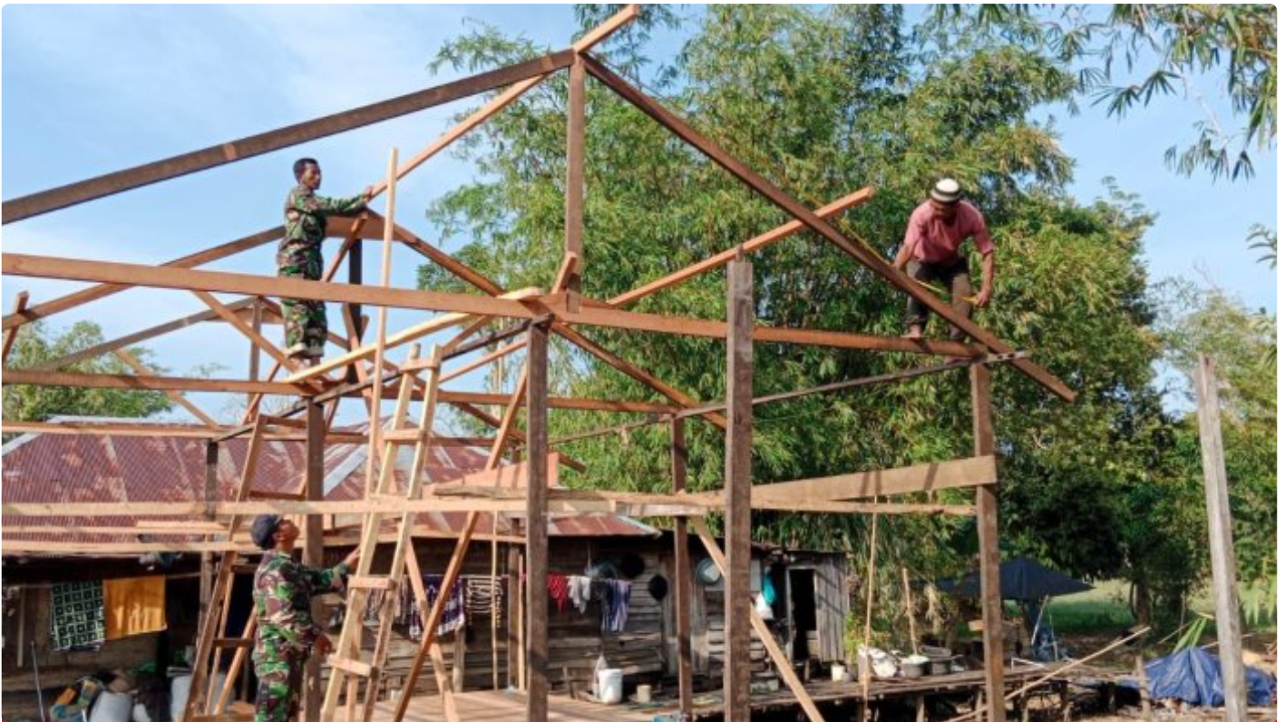
Karya Bakti TNI " Kodim 1006/Bjr Rehab Rumah Kini Sudah Pemasangan Lantai Dan Kuda - Kuda
