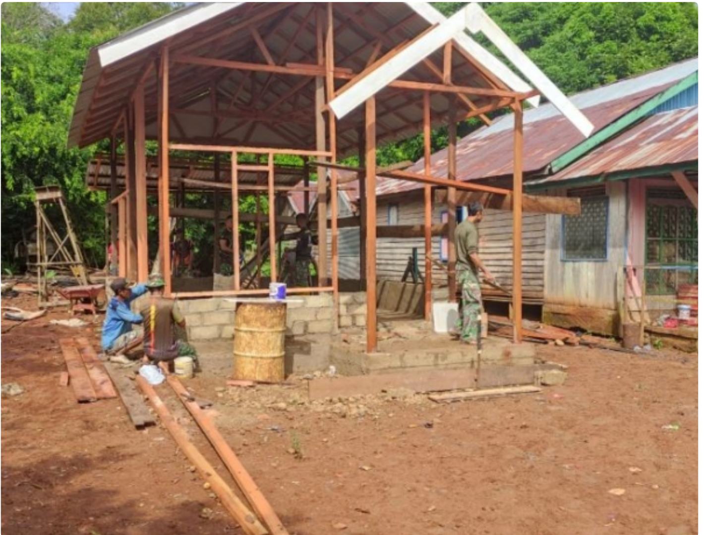
Atap Dan Tiang Teras Bedah Rumah Terpasang Program TMMD Kodim 1006/Banjar
